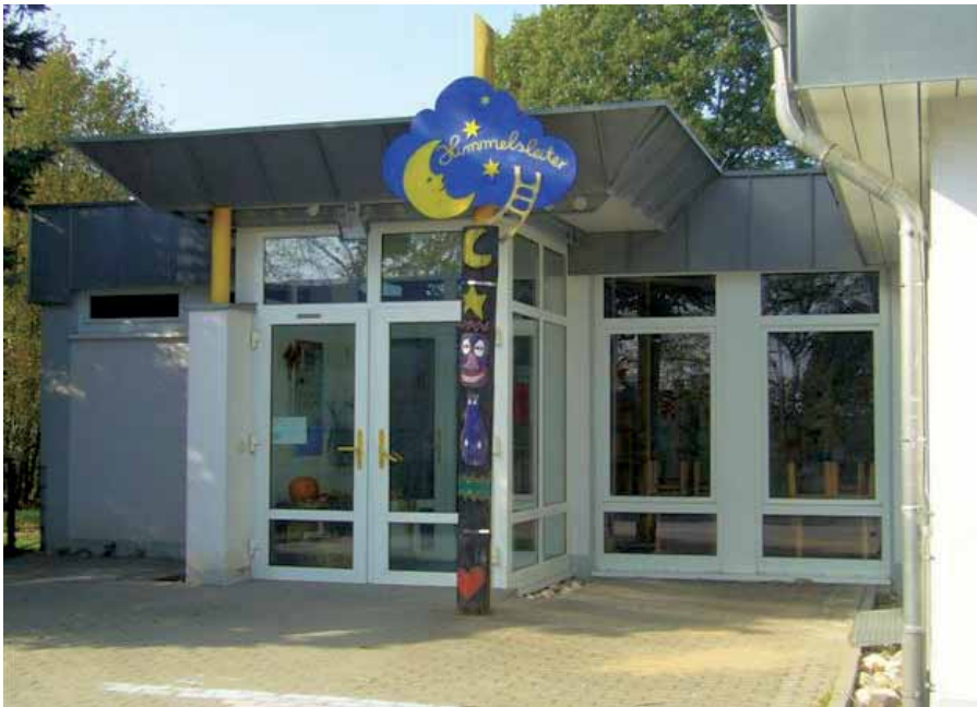
Eingang zur Himmelsleiter
